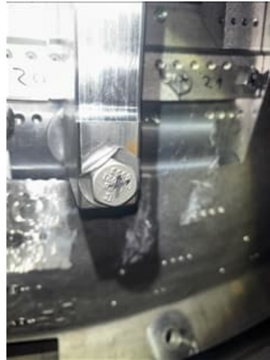
The lower inner manhole (1)
